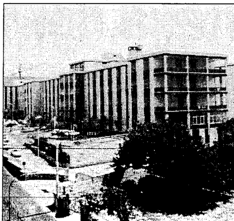
Il complesso dell'ospedale "Trigona" di Noto
